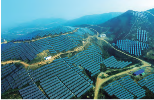
方大集团江西萍乡宣风镇分布式太阳能光伏发电站
