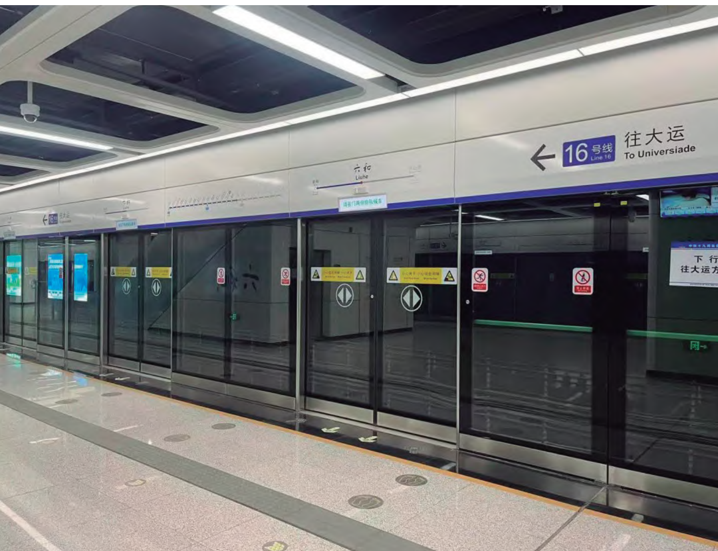
方大智源科技承建轨道交通屏蔽门系统的 深圳地铁 16 号线一期项目
