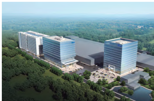
楚天科技三栋大楼幕墙工程
