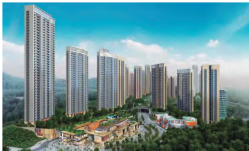
华为港投人才公寓项目
